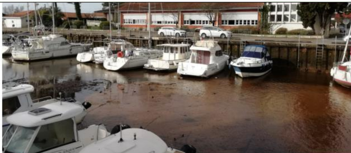
Quai Ouest (avec rempiètement en base) devant l'école
